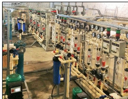
Установка с 8-ю аппаратами, установленными в одну ступень
